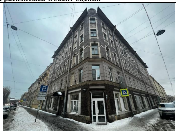
Фото 2. Вид здания, в котором расположен Объект оценки
