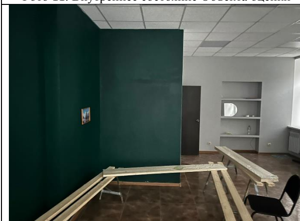
Фото 13. Внутреннее состояние Объекта оценки
